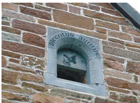
Figuur 1. Voorbeeld van een invliegopening voor vleermuizen, Ierland (Eurobats 2010).
